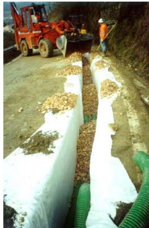
La posa tradizionale di condotte comporta l'apertura con mezzi meccanici di una trincea. A secondo del tipo di terreno incontrato nella posa e del materiale prescelto per le condotte, le modalità di scavo e di sistemazione possono variare.
